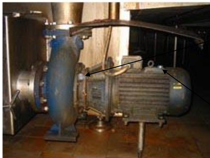
Platzierung von Messpads an einer Maschine
